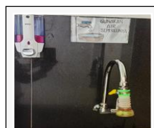
Penggunaan Kepala Kran/Sambungan Kran Air
